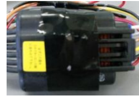
ビニールテープで固定
