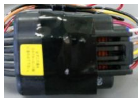
ビニールテープで固定
